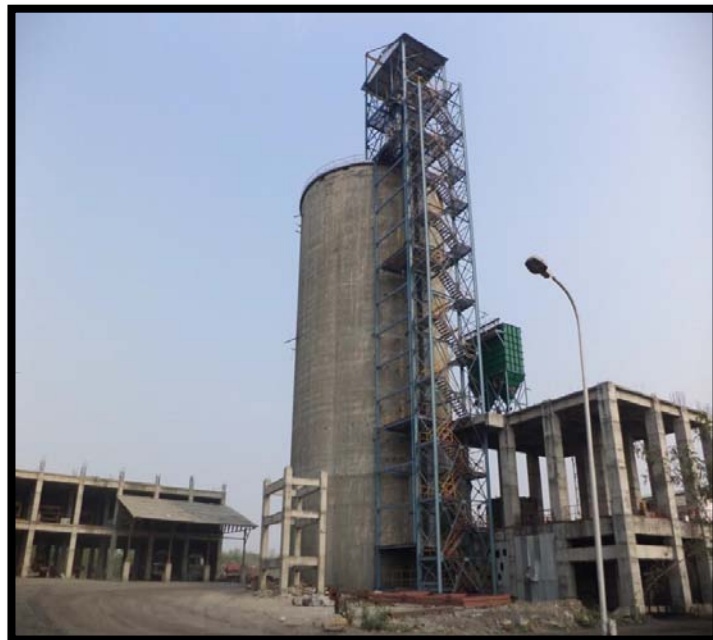
fly ash silo
